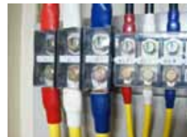
Messort mit abgedeckten Anschlüssen ⇓ Abdeckungen müssen für die Messung nicht entfernt werden
