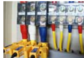
Messort mit abgedeckten Anschlüssen ⇓ Abdeckungen müssen für die Messung nicht entfernt werden
