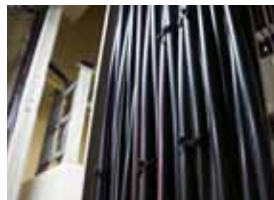
Messort ohne spannungsführenden Teile ⇓ an der Kabel- isolierung messen
